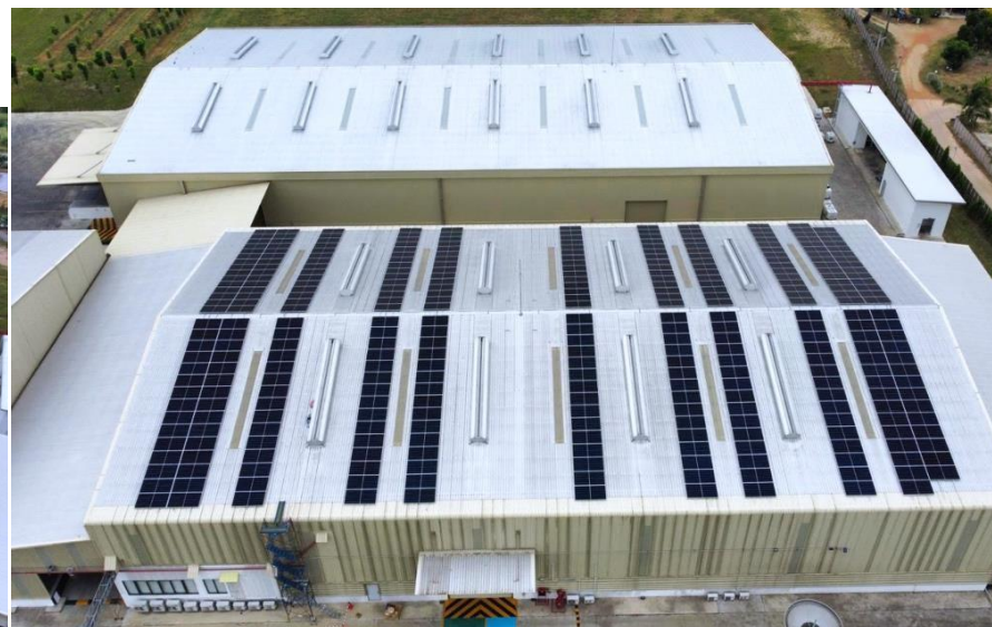
Hệ thống điện mặt trời công suất 180 kW tại Nhà máy Chonburi 2
